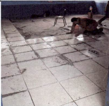
Foto1: Durante el remozamiento se procede a colocar el piso nuevo.
