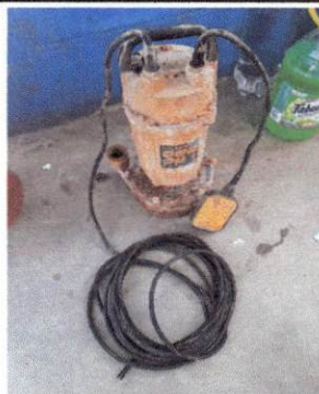
Foto 6: Se comprueba que la bomba ya no funciona y se procede a sacarla del pozo.
