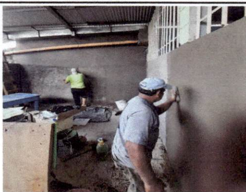
Foto 2: Se pican las paredes que son solamente de block, para prepararlas para echarles el repello correspondiente.
