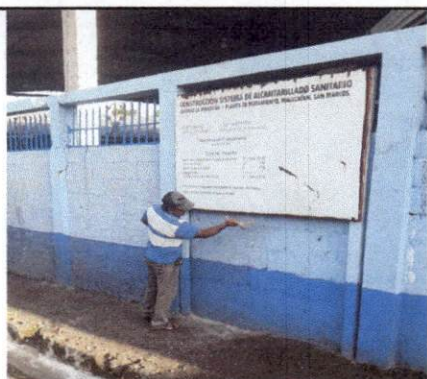
Foto 3: Se pican las paredes que son solamente de block, para prepararlas para echarles el repello correspondiente.
