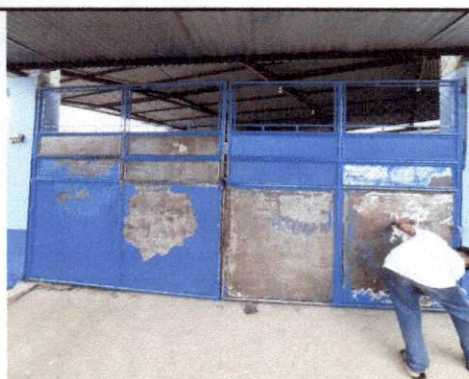
Foto 4: Durante el remozamiento se le da mantenimiento al portó principal de la escuela.
